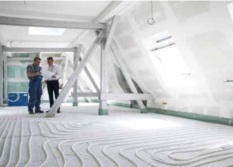
Uponor Klett EPS-Hartschaum mit aufkaschierter Klettgewebefolie
