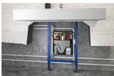
Vormontiert in Waschtischrahmen
