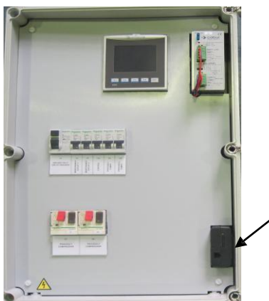
Kuva 3.3 Puhdistusyksikön ohjauskeskus, SIM-kortin paikka
