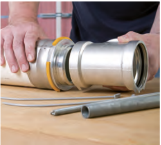
3 - Connecter l'embout Riser préalablement sertir sur la base Riser correspondante
