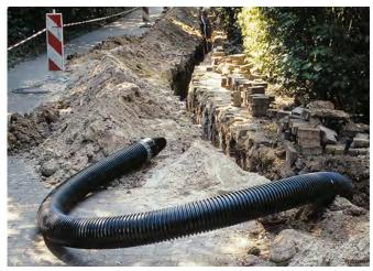
La flexibilidad de las tuberías Uponor Ecoflex permite su adaptación in situ sin problemas a casi cualquier situación de tendido. Es posible pasar por encima o por debajo de las líneas existentes y rodear los obstáculos para evitarlos. Incluso se puede tender el sistema de tuberías por debajo de una capa freática de 3 metros (0,3 bares).
