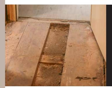
Anspruchsvolle Sanierungsaufgabe: Die Böden der Wohnung bestanden aus einer mit Lehm gefüllten Dielenschalung ohne Dämmung. Der Trittschallschutz war mangelhaft.
