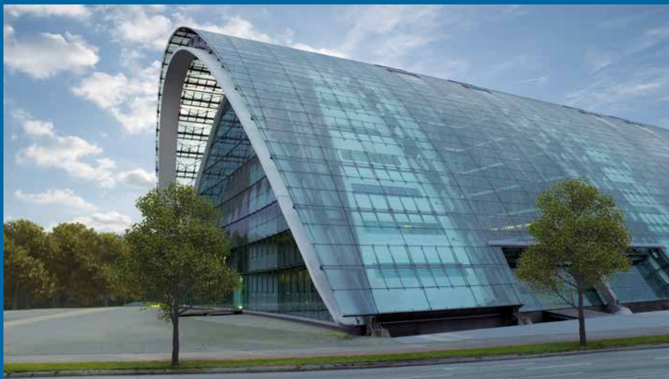
Berliner Bogen, administrativní budova v Hamburku, Německo
