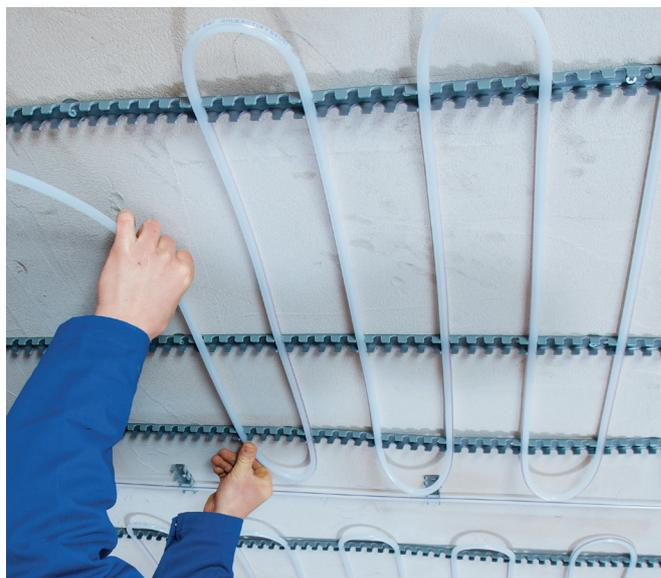
*Anschließend werden die Systemrohre möglichst dralfrei in die Uponor Fix Klemmschienen eingedrückt. Bei Bedarf können abstehende Rohrschlaufen im Umlenkungsbereich zusätzlich mit Schienenstücken fixiert werden.*
