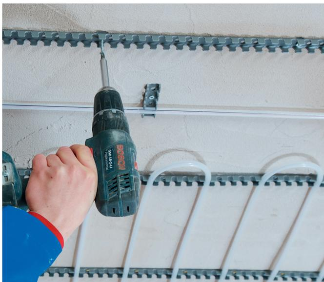
*Zunächst werden die Uponor Fix Klemmschienen unter der tragenden Decke in dem vorgegebenen Abstand befestigt. Kurze Schienenstücke können dabei auch zur Befestigung der Zuleitungen verwendet werden.*
