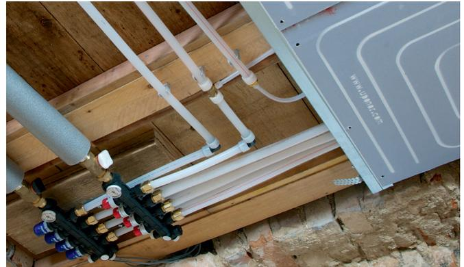
Beispiel: Anschluss der Uponor Renovis Pannels in der Decke an einen Uponor Vario PLUS Verteiler, Einzelraumregelung über thermische Stellantriebe und Smatrix Raumfühler.
