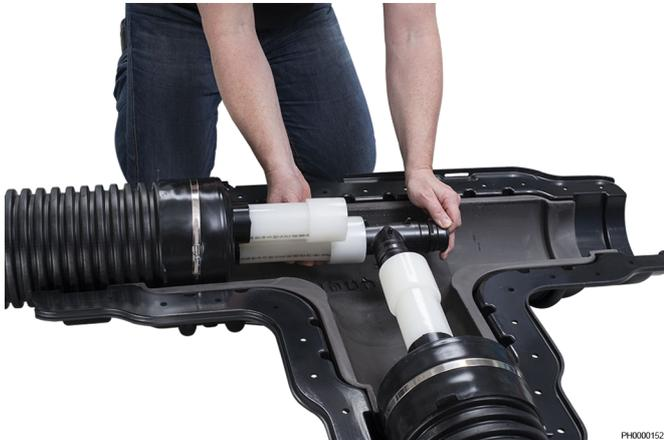
Le raccord Uponor Q&E est basé sur une méthode où un tube Uponor PE-Xa est progressivement agrandi avec une bague Q&E (PEX) montée à l'extérieur, puis en lui permettant de se rétracter sur un embout de raccordement. La technique peut être utilisée car le matériau Uponor PEX peut quasiment revenir à sa taille d'origine, même après une très grande dilatation.
