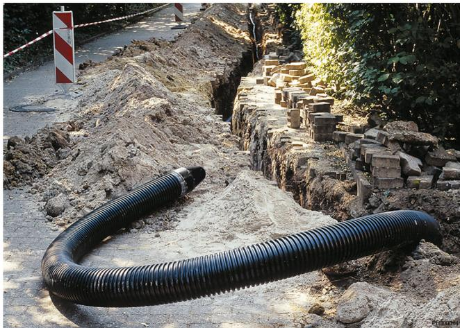
La flexibilité des tubes Uponor Ecoflex permet une adaptation sans problème sur site dans quasiment toutes les conditions d'acheminement. Il est possible de passer au-dessus ou en dessous des lignes existantes, tandis que les obstacles peuvent simplement être évités. Même la pose du système de canalisation sous une nappe phréatique de 3 mètres (0,3 bar) est autorisée.
