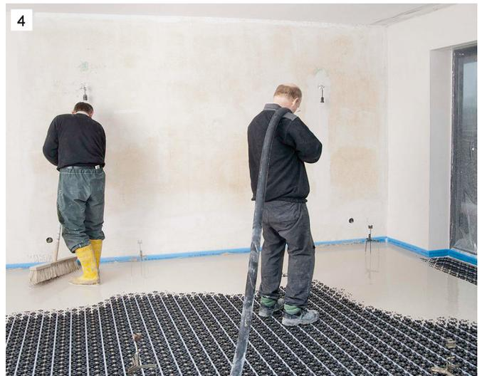
4) Auf die fertig verlegte Uponor Minitec Fläche wird abschließend die Ausgleichsmasse mit nur minimaler Überdeckung aufgebracht und nivelliert. Die Lochung des Folienelements sorgt für eine optimale Verbindung von Ausgleichsmasse und Untergrund.
