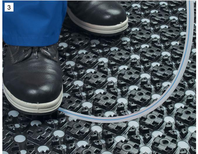
3) Für die Verlegung der Uponor Minitec Comfort Pipe Rohre sind keine Werkzeuge erforderlich. Sie werden einfach in einem Winkel von 90° oder 45° zwischen die Noppen des Folienelements eingedrückt.
