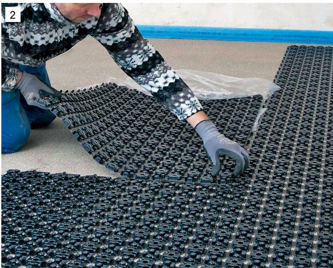
2) Anschließend werden die selbstklebenden Uponor Minitec Folienelemente auf dem vorbereiteten Untergrund mit einem Wandabstand von ca. 5 cm ausgelegt und mittels Dreiecksnoppen miteinander verbunden.
