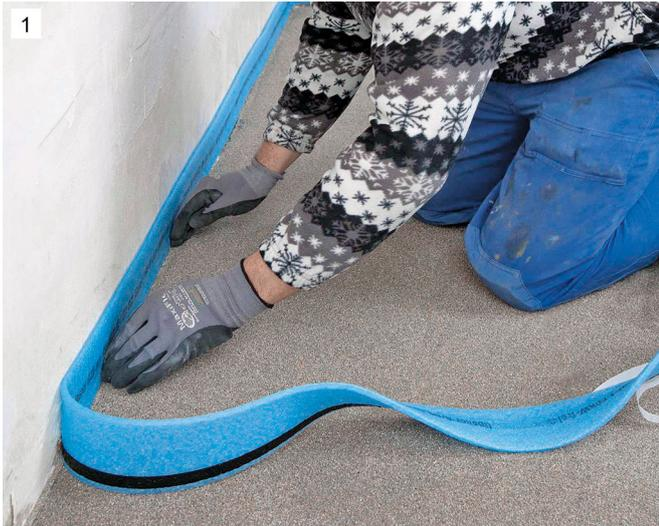
1) Der Uponor Minitec Randdämmstreifen mit rückseitigem Klebestreifen wird lückenlos an alle aufsteigende Bauteilen wie Wänden, Stufen usw. aufgestellt.
