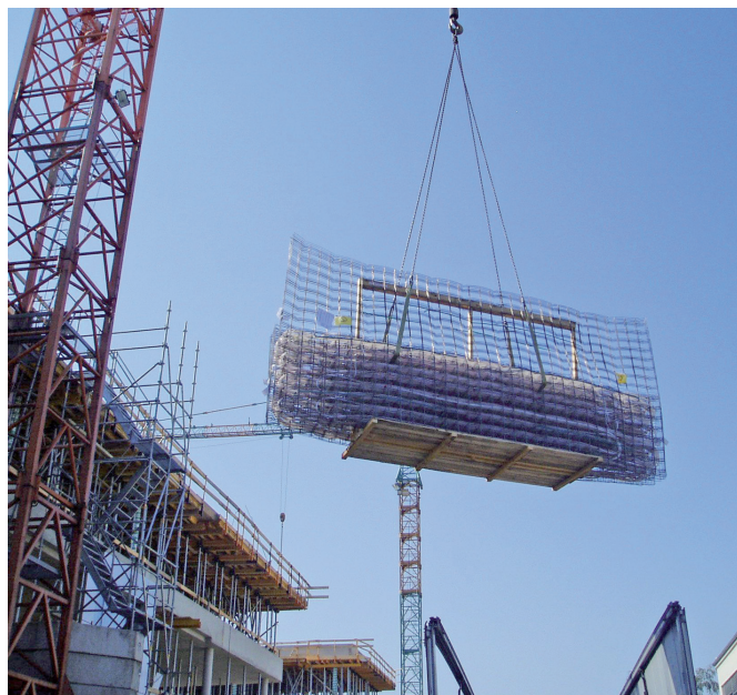
Levage correct d'un paquet de modules Uponor Contec avec des modules verticaux à l'aide d'une grue.
