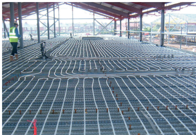
Uponor Contec dans un plafond à panneaux trapézoïdaux.
