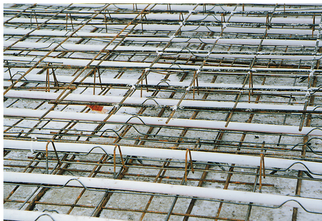
Modules Uponor Contec posés sur une grille.
