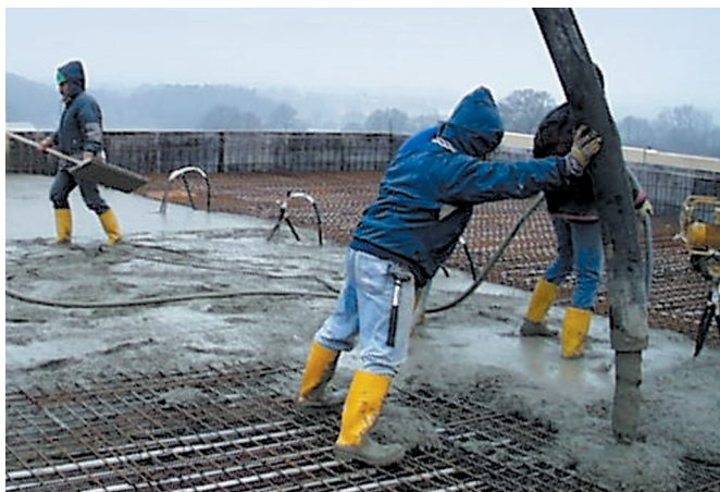
Coulage du plafond en béton sur place
