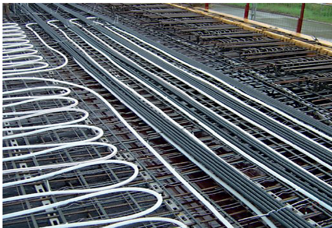
Les modules Uponor Contec sont installés au milieu du plafond (zone structuellement neutre).
