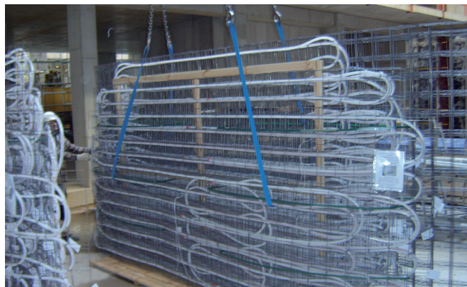
Paquet de modules avec modules Uponor Contec verticaux.
