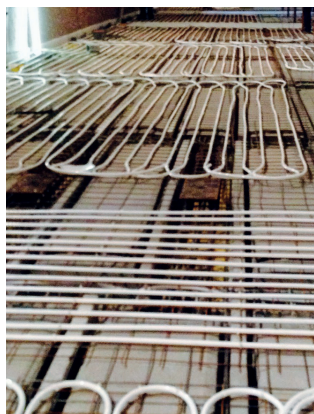
Installation du système Uponor Contec dans un plafond en dalle nervurée.
