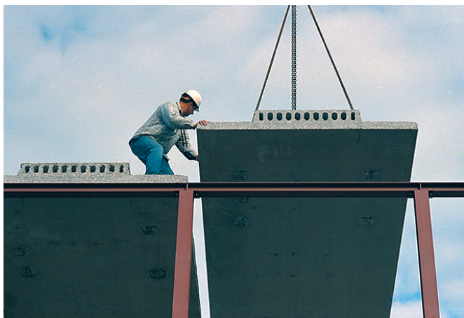
Installation des éléments thermo-actifs préfabriqués en béton sur le chantier.
