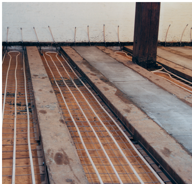
Pose Uponor Contec dans l'espace entre les poutres du plafond.
