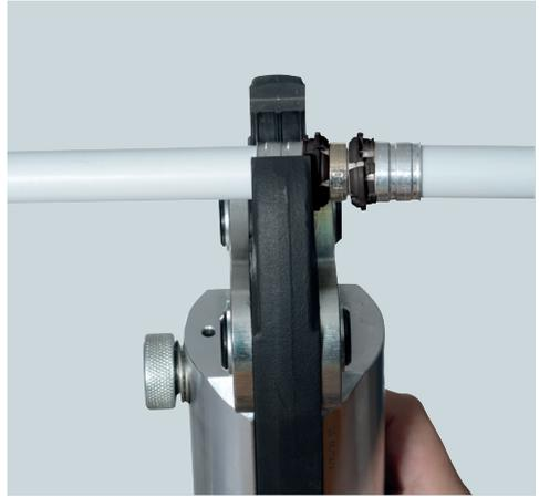
Die Pressbacke mit der gleichen Farbcodierung wie der Fitting wird an die Pressbackenführung der Presshülse angelegt.
