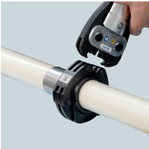
Das entgratete Verbundrohring bis zum Anschlag in den Fitting einstecken. Dann passende Pressschlinge (gleiche Dimension und gleicher Farbcode wie Fitting) bis zum farbigen Anschlag um die Presshülse legen.
