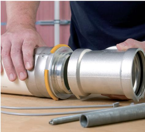
Mittels innovativer Stecktechnik werden Pressadapter und Grundkörper miteinander verbunden.
