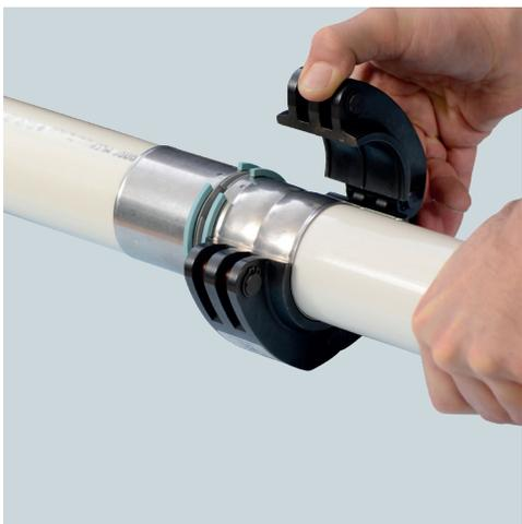
Nach dem Verpressen ist die erfolgreiche Verpressung durch eine deutliche Verformung der Presshülse sichtbar (Sichtkontrolle).
