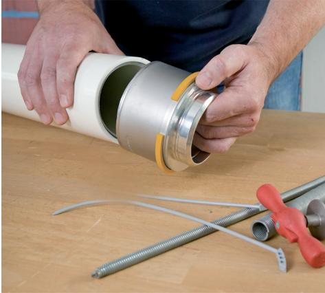
Zunächst wird der Pressadapter in das rechtwinklig abgelängt und entgratete Verbundrohr eingesteckt.
