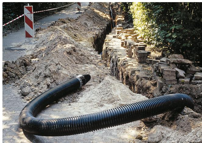
Flexibilita potrubí Uponor Ecoflex umožnuje bezproblémové přizpůsobení na místě téměř jakkoli volené trase potrubí. Potrubí je možné vést přes stávající vedení nebo pod ním, přičemž se lze jednoduše vyhýbat překážkám. Potrubní systém je povoleno vést až 3 metry (0,3 baru) pod hladinou spodní vody.
