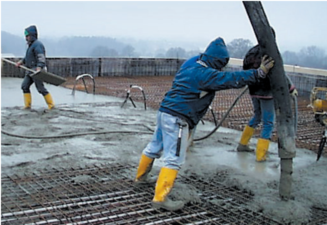
Betonieren der Decke vor Ort.
