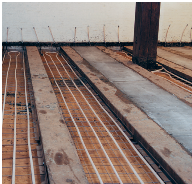
Contec Verlegung im Balkenzwischenraum der Decke.
