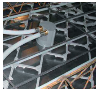
Integration der thermischen Steckdose Contec T2 im Betonwerk.
