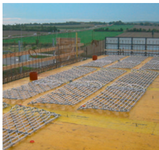
Anordnung der vorgefertigten Contec ON Module auf der Schalung gemäß Planung.
