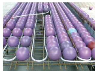
Cobiax® Module mit Uponor Contec.
