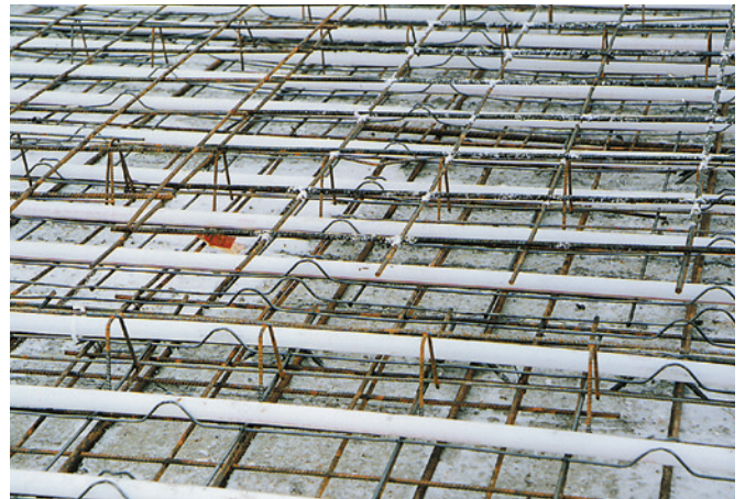
Contec Module auf Gitterträger aufgelegt.
