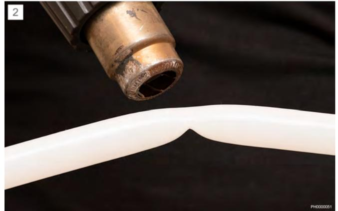
Тщательно и равномерно нагрейте поврежденный участок с помощью строительного фена, перемещая его по окружности трубы на протяжении всего процесса.
