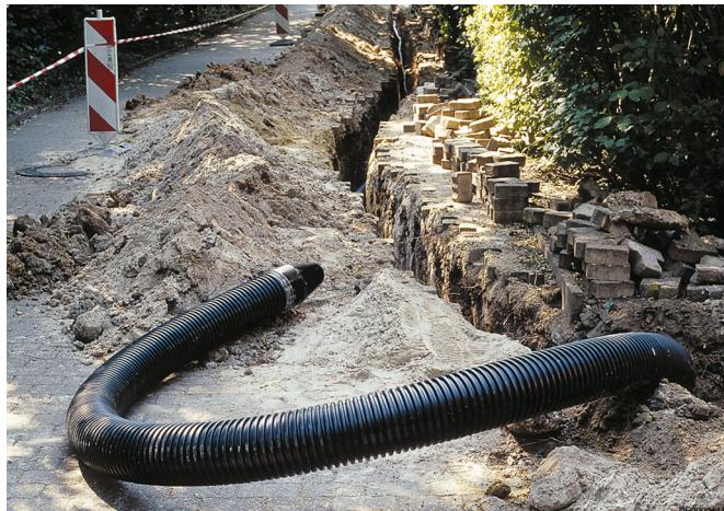
Uponor Ecoflex cauruļu elastība ļauj bez problēmām pielāgoties uz vietas gandrīz jebkādiem izvietošanas apstākļiem. Ir iespējama izvietošana virs vai zem esošā linijām, savukārt šķēršļus var vienkārši apieit. Ir atļauta pat cauruļu sistēmas ieguldīšana zem 3 metru (0,3 bāri) gruntsūdens līmeņa.
