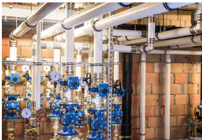
Le système de raccords modulaires Uponor RS pour les tubes de distribution et les colonnes montantes vous permet de réaliser tous les joints à sertir requis en toute sécurité et facilement sur l'établi. Ce n'est qu'ici que des outils lourds sont nécessaires pour sertir les connexions. Sur site, les tronçons de tubes pré-assemblés sont ensuite insérés dans les raccords sans outils et verrouillés.
