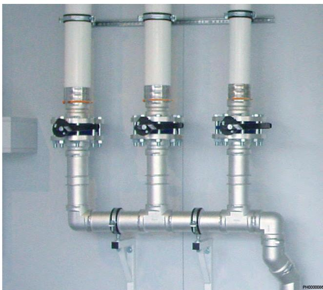
Structure de collecteur principale flexible - avec le système de montage modulaire et les adaptateurs de distance associés, des collecteurs de différentes tailles peuvent être fabriqués de manière flexible en quelques étapes simples.
