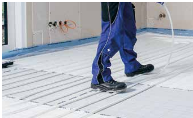
Die Zwischenräume werden mit Uponor Klettplatten aufgefüllt, das Fußbodenheizrohr wird schnell und einfach über die gesamte Raumfläche verlegt.
