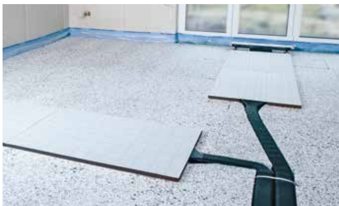
Uponor Comfort Air wird zusammen mit den Pluggit Pluggflex Lüftungskanälen verlegt. Entsprechende Adapter ermöglichen eine fachgerechte Einbindung in das Lüftungssystem.
