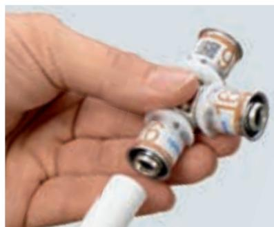
Inserte el tubo multicapa UPONOR Uni Pipe PLUS en el accesorio. No es necesario escariar el extremo del tubo previamente.
